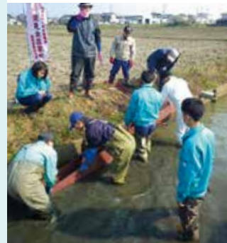
④ 集落総出で魚道を設置
