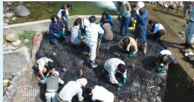
② 間伐材等を利用した手づくりの魚道を設置
