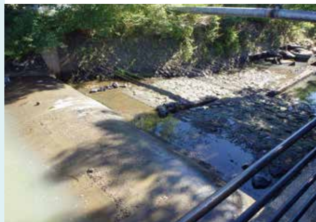
② 手前の膨らんでいる部分がラバーダム
