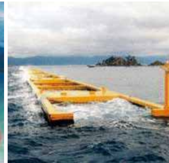
③ 消波施設の整備
