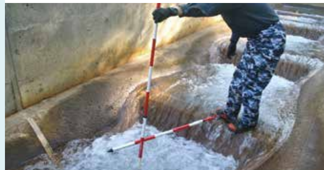
④ 魚道内(台形断面)の通水状況
