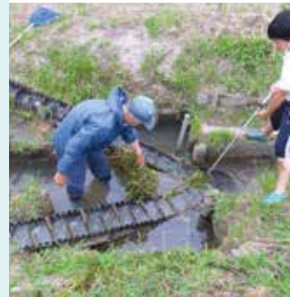
① 水路と水田を結ぶ水田魚道
